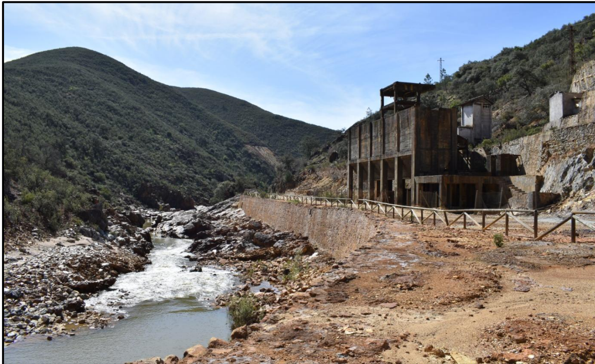
Planta de tratamiento junto al río Odiel.
