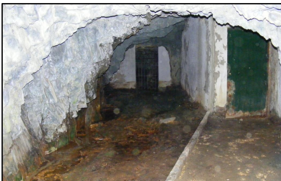
Interior del socavón de la Parra Gorda.
