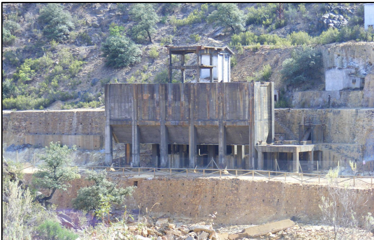
Vista frontal de la planta de tratamiento.
