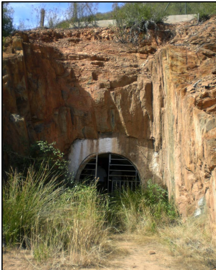
Entrada al socavón de la Parra Gorda.
